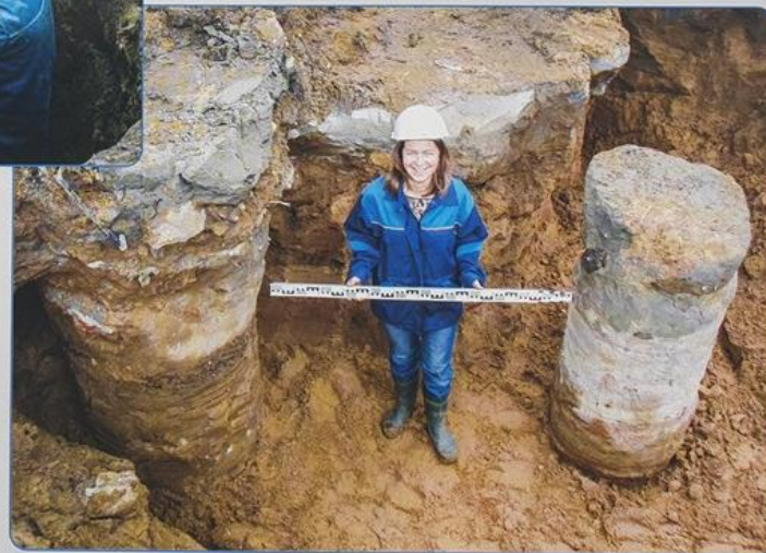
ГРУНТОЦЕМЕНТНАЯ КОЛОННА ЖЕТ 1. ДИАМЕТР 800 ММ.
